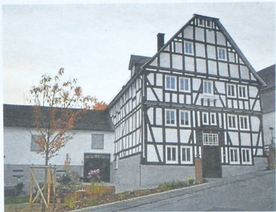
Das Fachwerkhaus „Hof Hallenberg“ wurde aufwendig saniert und umgebaut. Foto: Helmut Japes
